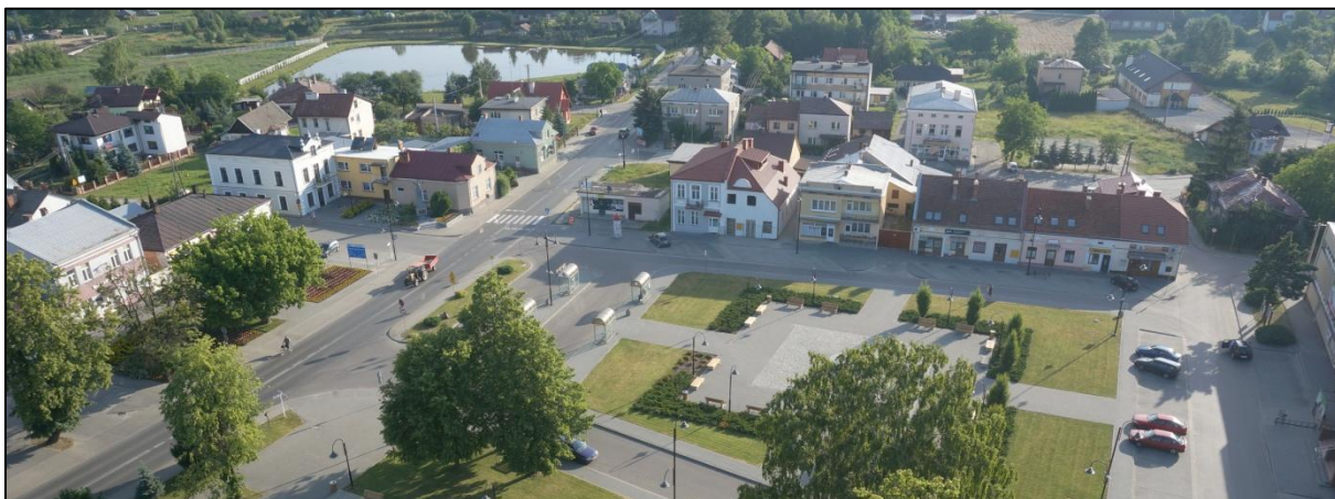
Wschodnia pierzeja żołyńskiego rynku (widoczne dwie zatoki autobusowe i stare kamienice, w obrębie rynku znajduje się około 100 miejsc parkingowych).
